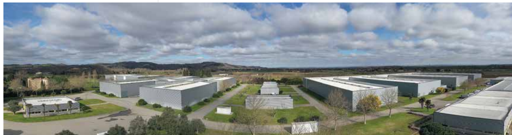
SITE LOGISTIQUE À GARIÉLAT, À PAMIERS (09)
